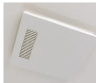
換気暖房乾燥機 (ミスト機能含む)
